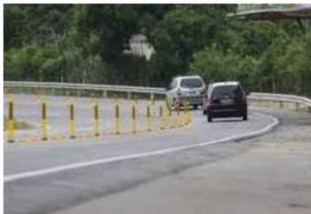
Figura 03: Utilização de balizador para divisão de faixas em pistas simples.
