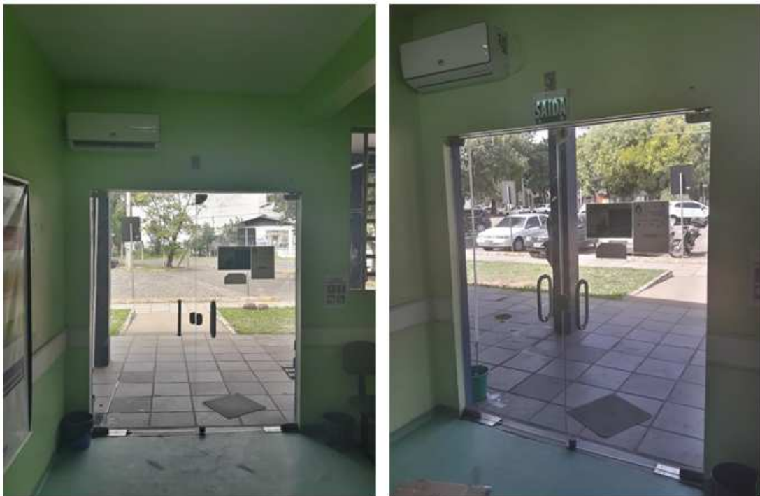
Figura 5 – Sinalização da saída (a) antes e (b) depois
