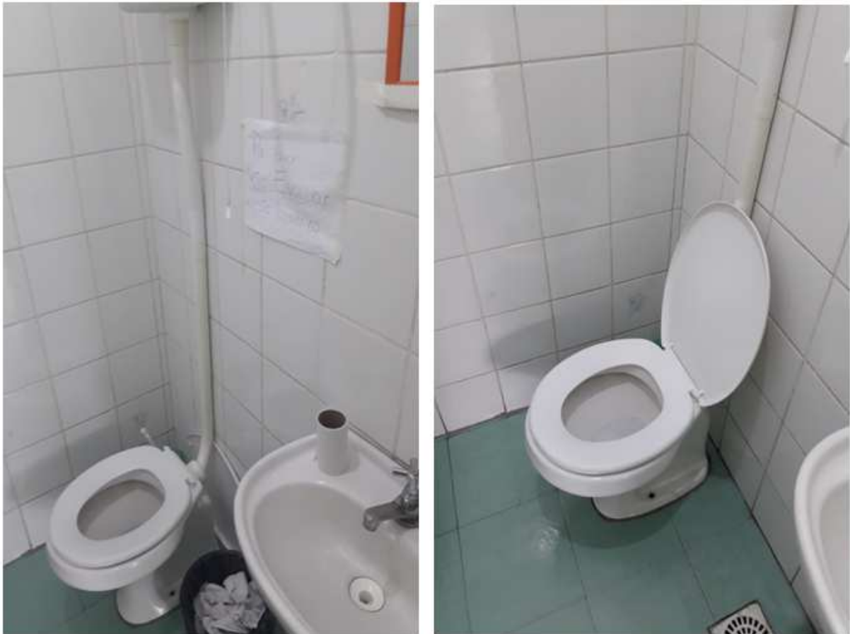
Figura 2 – Banheiro da enfermagem (a) antes e (b) depois
