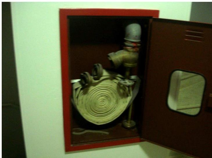
Figura 2 – Sistema de hidrante tipo 1.
