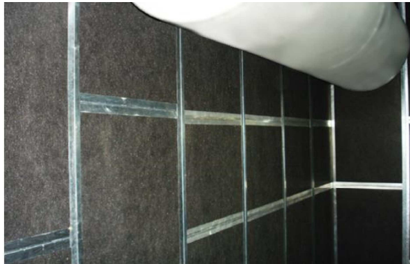
Figura 7. Painel de lã de vidro com acabamento em TNT Fonte: Internet
