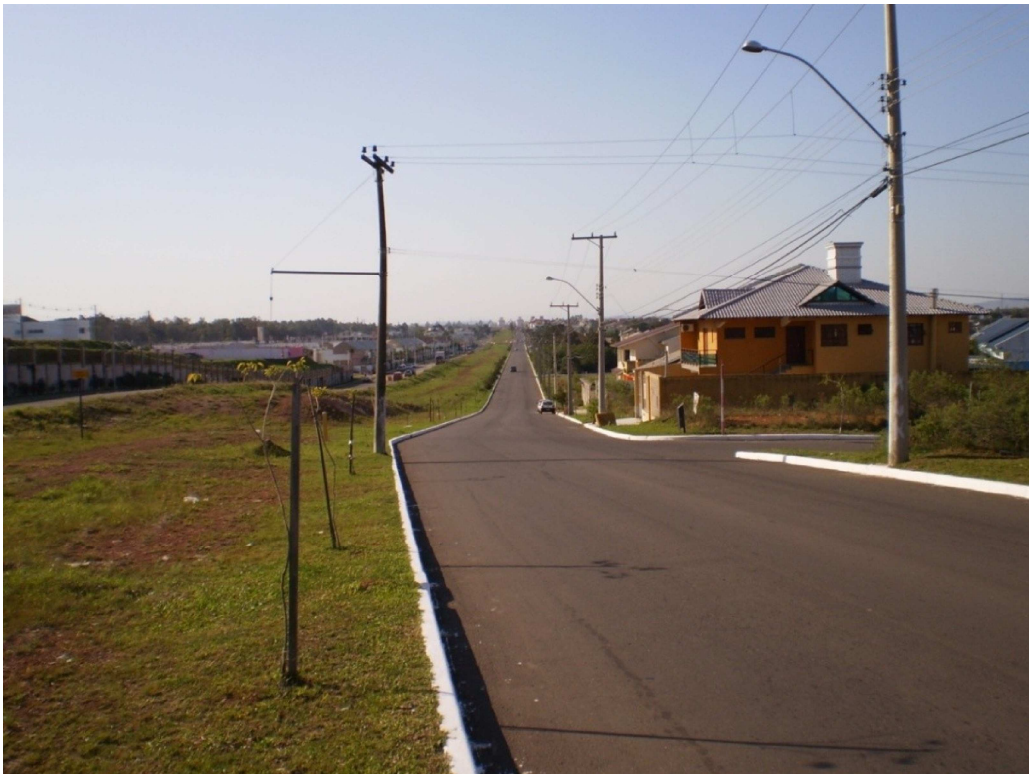
Figura 52 – Avenida Açucena – desocupação das áreas lindeiras, liga a Av. Santos Ferreira e a Avenida Boqueirão – Integração Local. Fonte: Foto registrada pelo autor - 2012
