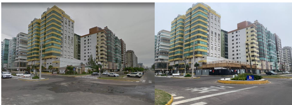
Figura 45: casa de alvenaria na Avenida Beira Mar em março de 2019; nova edificação em construção, Julho de 2021.
