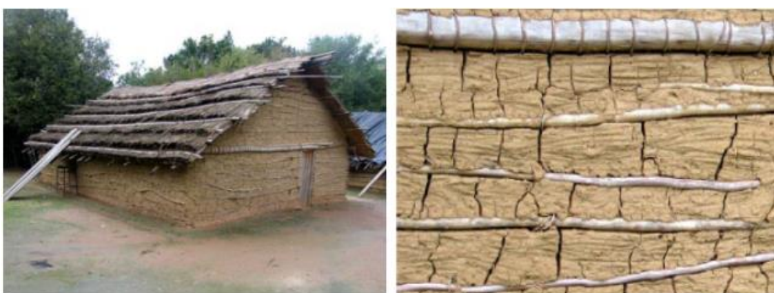
Figura 7 - Casa típica comunidade indígena Guarani construída pela técnica de Pau-a-pique
