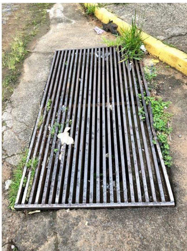
Fotografia 5 – Boca de lobo onde passa a galeria
