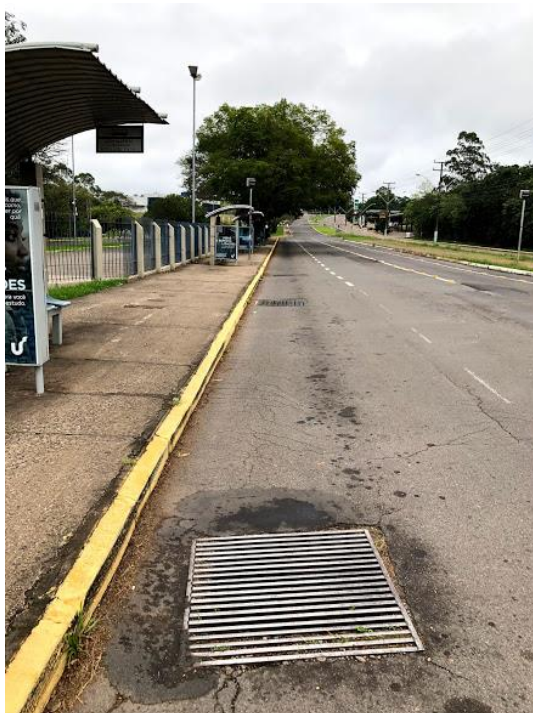
Fotografia 10 – Bocas de lobo ao longo da Avenida Unisinos
