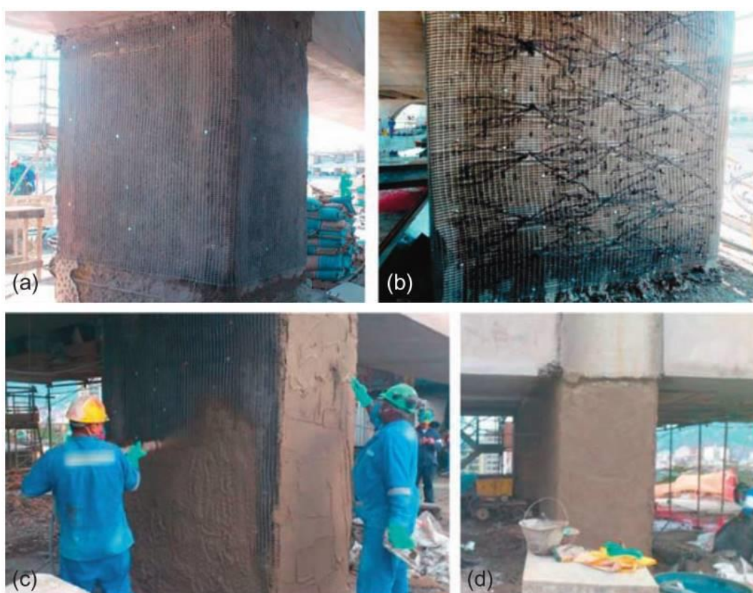
Figura 10 – Reforço de pilares no Estádio Maracanã
