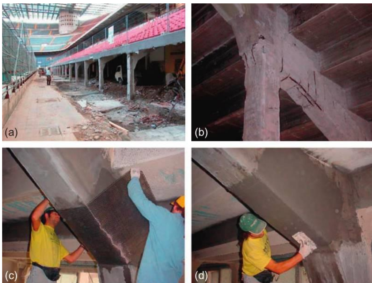
Figura 8 – Reforço de vigas e pilares do Estádio San Siro, na Itália
