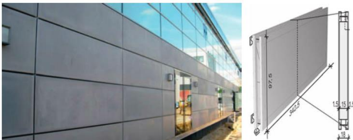
Figura 4 – Painel sanduíche em edificação em Aachen, na Alemanha
