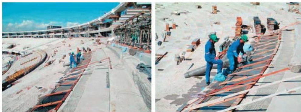
Figura 11 – Reforço das arquibancadas do Estádio Maracanã
