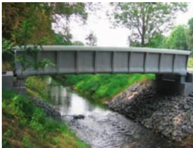
Figura 6 – Passarela de concreto têxtil em Oschatz, Alemanha
