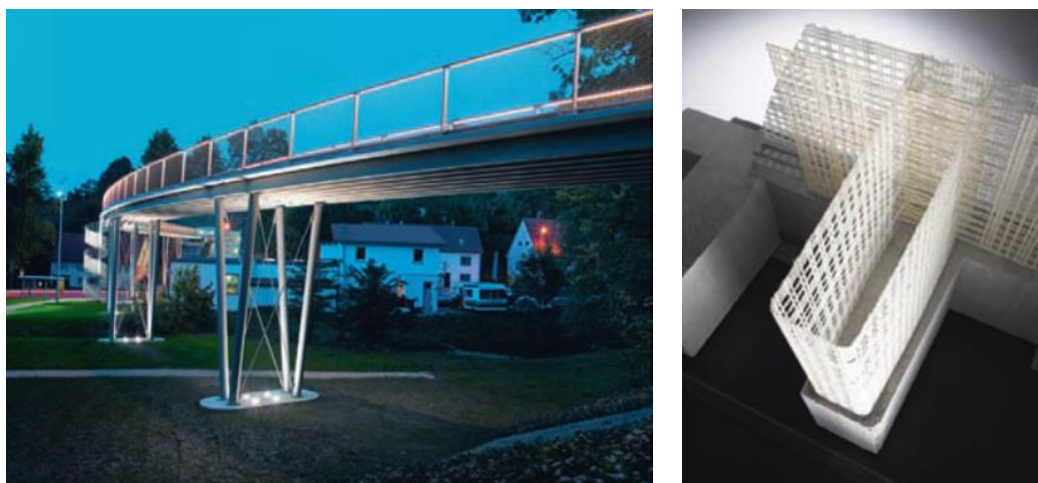
Figura 7 – Passarela em Albstadt, Alemanha
