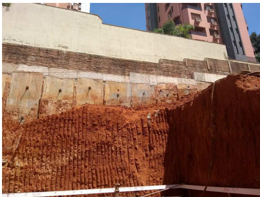
Fotografia 1 - Escavações presentes na área de estudo
