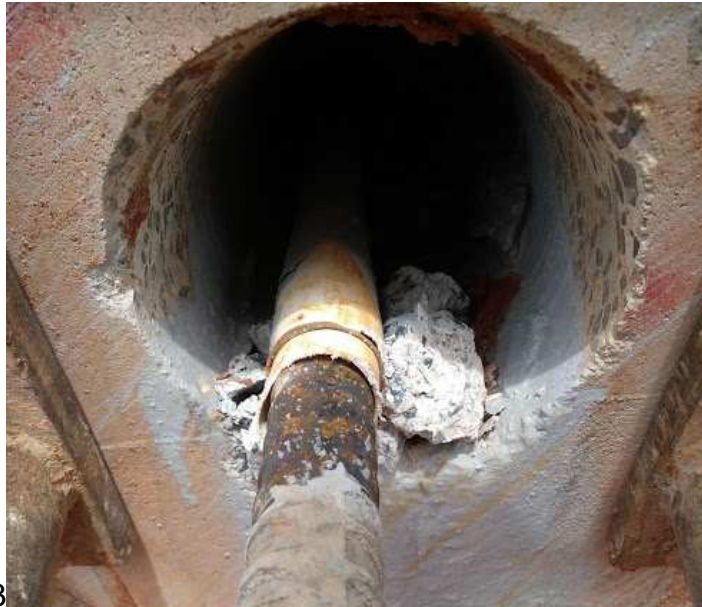
Fotografia 10 - Proteção e detalhe do grampo
