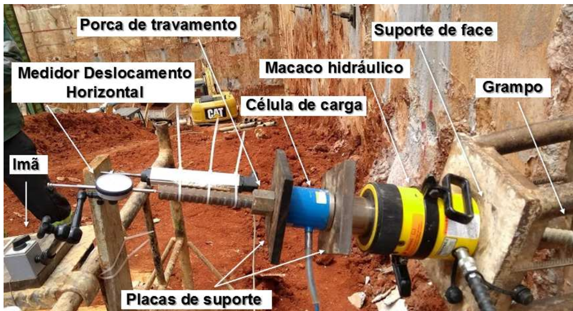
Figura 28 - Equipamentos empregados no ensaio de arrancamento
