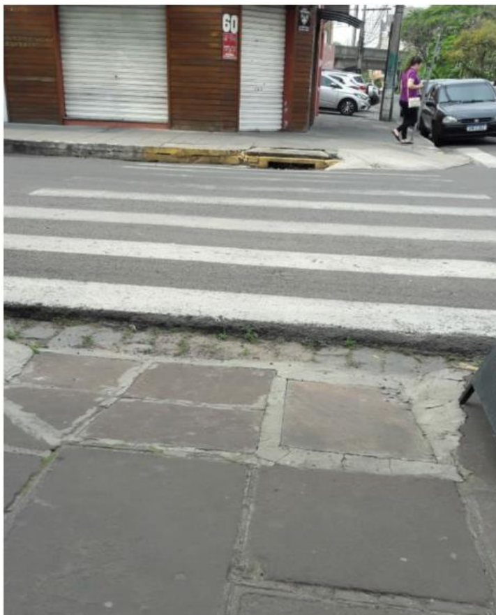
Figura 26 - Rampas de acesso
