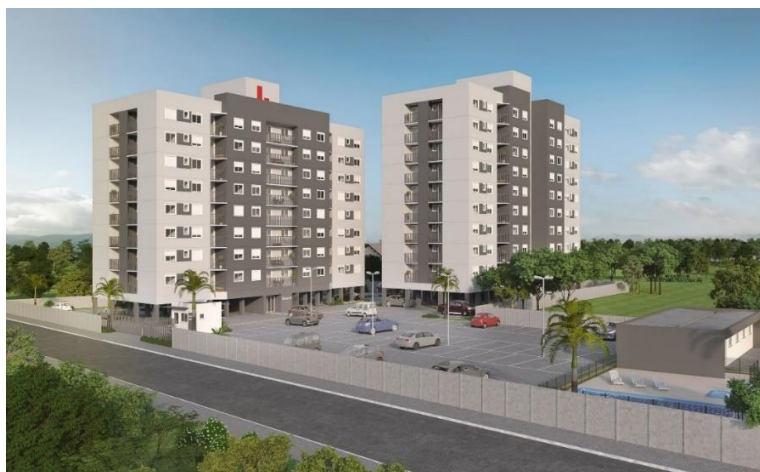
Figura 33 – Empreendimento 1 (alvenaria estrutural sob pilotis)
