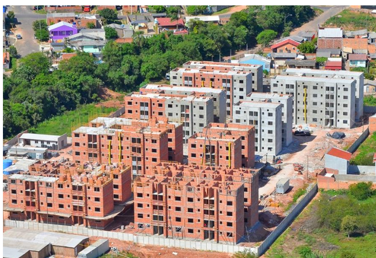
Fotografia 2 – Residencial de alvenaria estrutural com blocos cerâmicos
