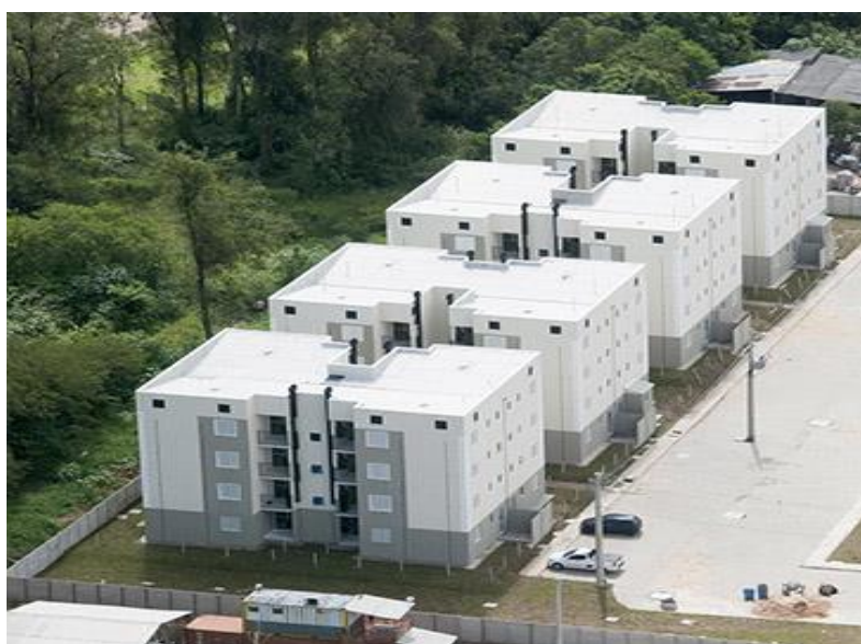
Fotografia 1 – Residencial de alvenaria estrutural com blocos de concreto
