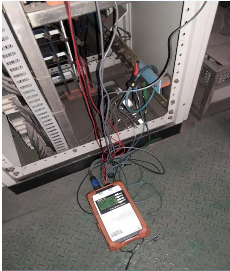
Figura 24 – Instalação do analisador de energia
