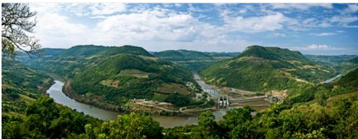
Figura 5. 1 – Usina hidrelétrica 14 de Julho
