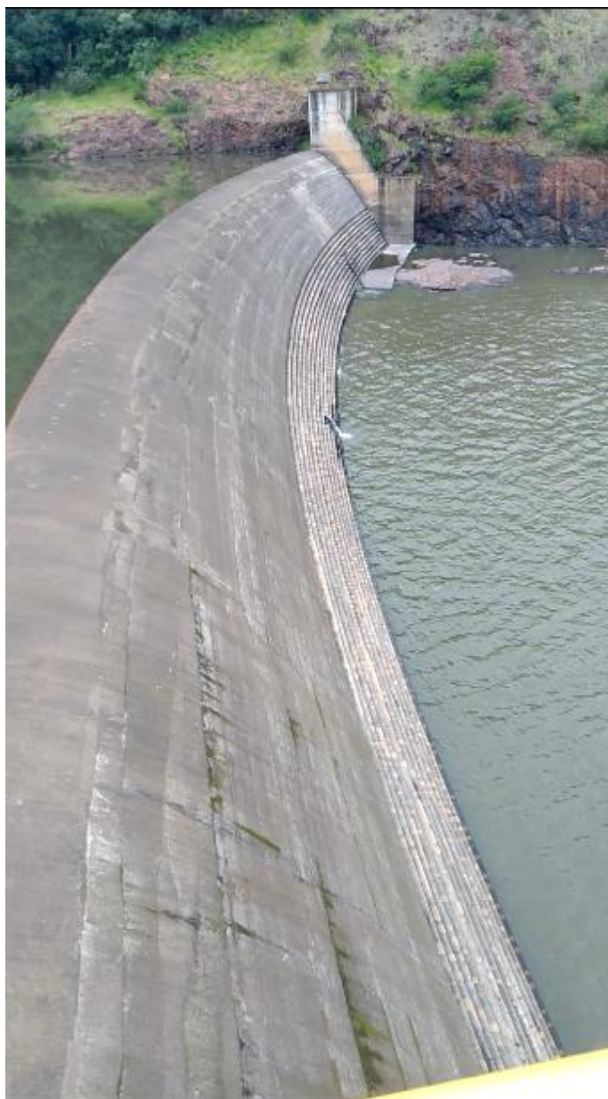
Figura I- 2 – Barragem e vertedouro de soleira livre da usina Monte Claro
