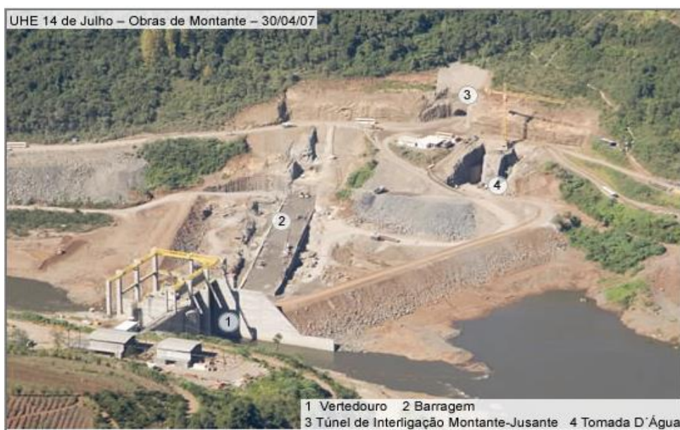
Figura 5. 3 – Usina 14 de Julho no período de obras a montante
