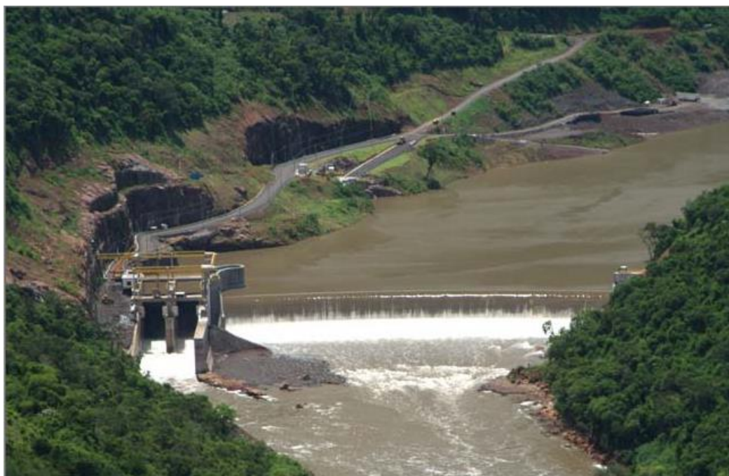
Figura 5. 5 – Usina hidrelétrica Monte Claro
