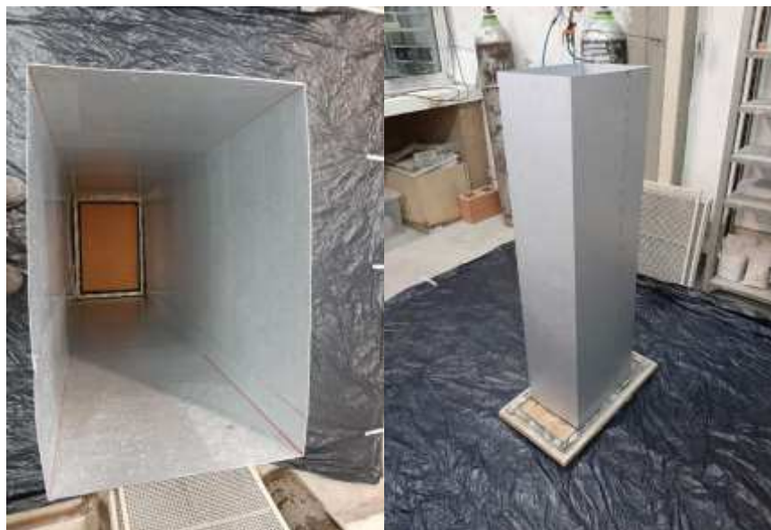
Figura 16 - Aplicação de argamassa de revestimento com uso de tubo de queda
