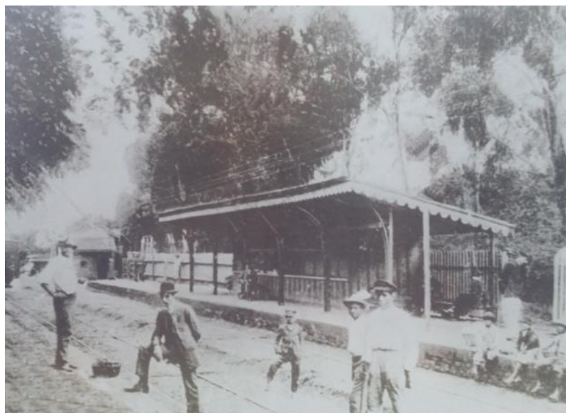
Figura 3 – Estação de Trem de Canoas (c. 1910).
