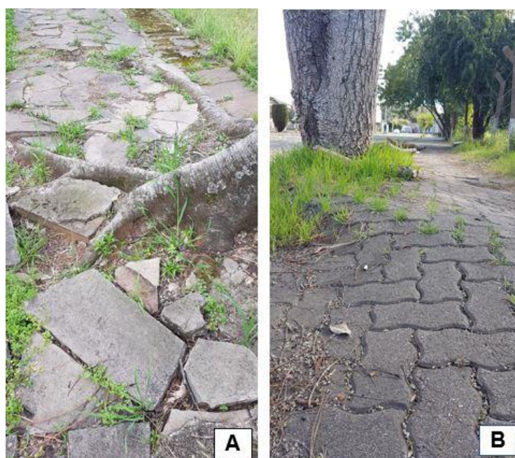
Figura 5 - Exemplares de A - Schizolobium parahyba , B - Enterolobium contortisiliquum , com área livre insuficiente e raízes quebrando o passeio público.
