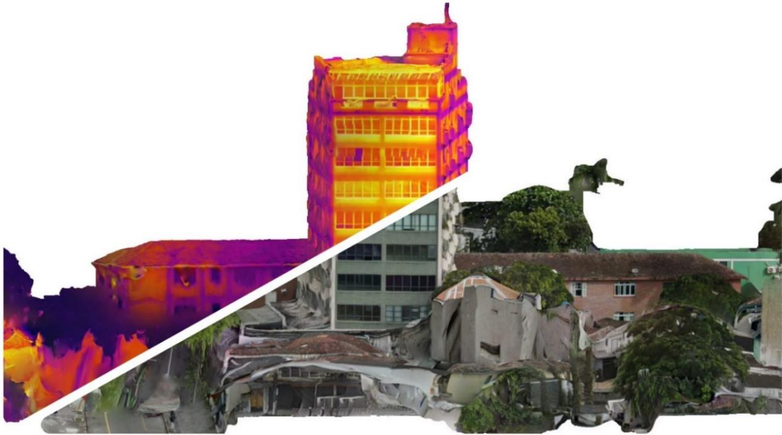
Figura 40 – Comparação entre mosaicos IR e RGB da fachada Norte
