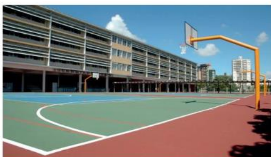
Foto 4 – Prédio do Ensino Fundamental II e Ensino Médio.
