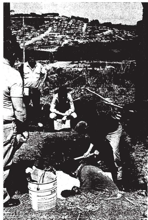
Preparação do Terreno para Construção de banheiros.
