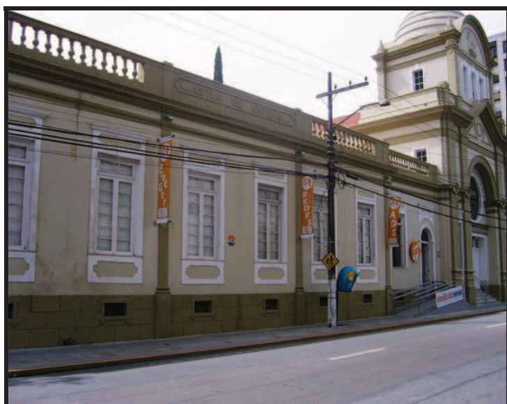
Prédio da FATEC
