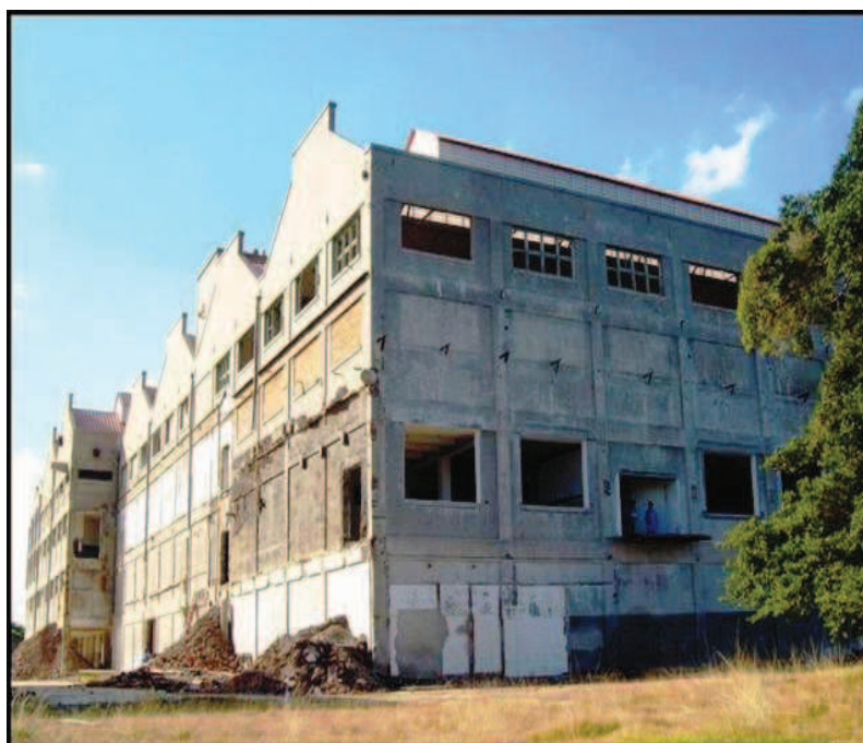
UFPEL Construção do novo Campus.
