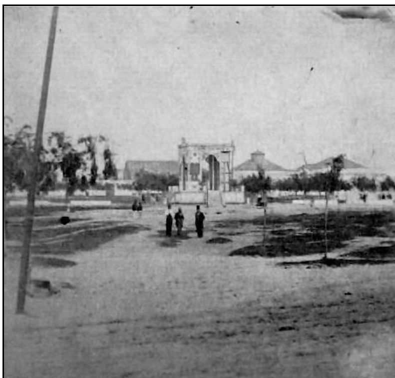
FIGURA 02 – “Vista parcial da Praça Tamandaré entre 1892 e 1900” FONTE: Fototeca do Centro Municipal de Cultura “Inah Emil Martensen”.
