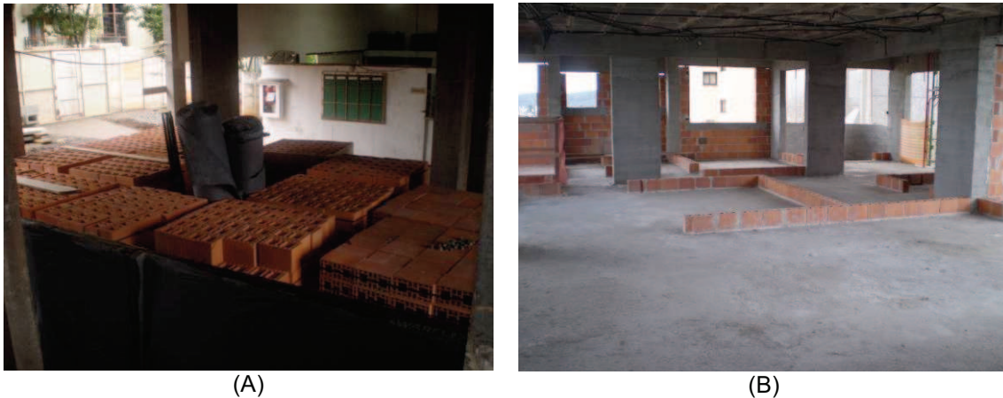
Figura 12 – (A) Blocos Cerâmicos armazenados em “ pallets ”. (B) Início das alvenarias
