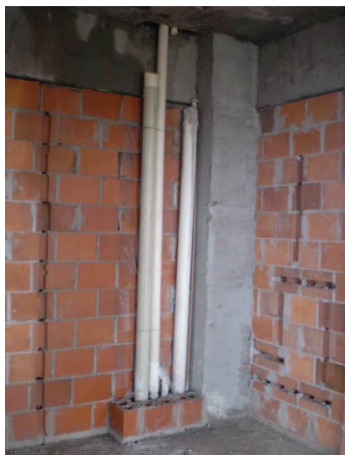
Figura 19 – Alvenaria com Blocos Cerâmicos.
