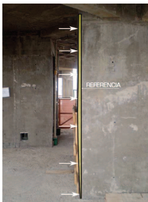
Figura 39 – Deformação na Geometria do P26.
