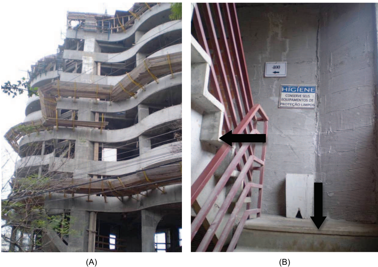
Figura 22 – (A) Vista Geral externa da Estrutura. (B) Detalhe da Escada pré-fabricada.
