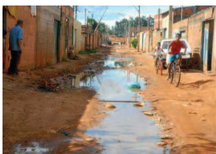
Figura 3.1: Esgoto a céu aberto.
