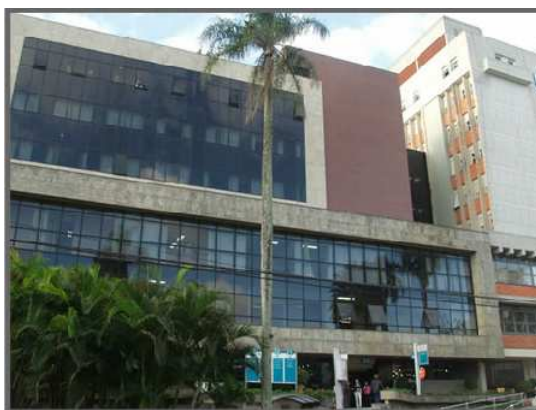
Figura 14 - Ampliação da Capacidade de Atendimento do HMD
