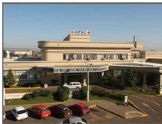
Figura 19 - Hospital de Pronto Socorro - Canoas/RS
