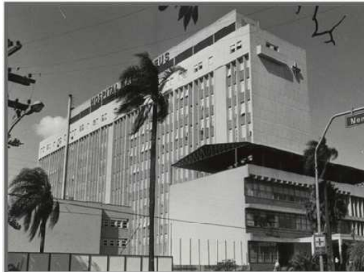
Figura 4 - Construção do prédio do Hospital e Maternidade Beneficente Mãe de Deus – Porto Alegre/RS
