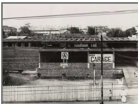
Figura 2 - Terreno e do prédio em construção – Porto Alegre/RS
