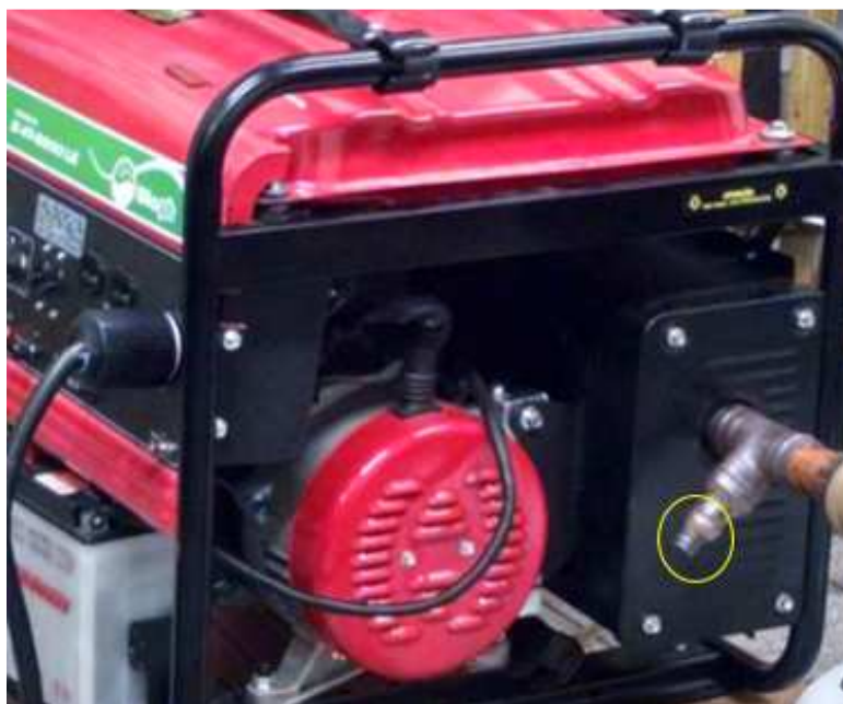
Figura 3.14 – Ponto de medição da temperatura dos gases na saída do escapamento e dos níveis de emissões.
