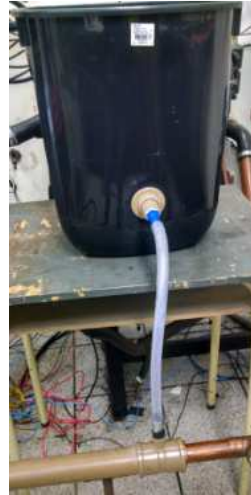
Figura 3.11 – Tanque de água e conexão de entrada no trocador de calor.
