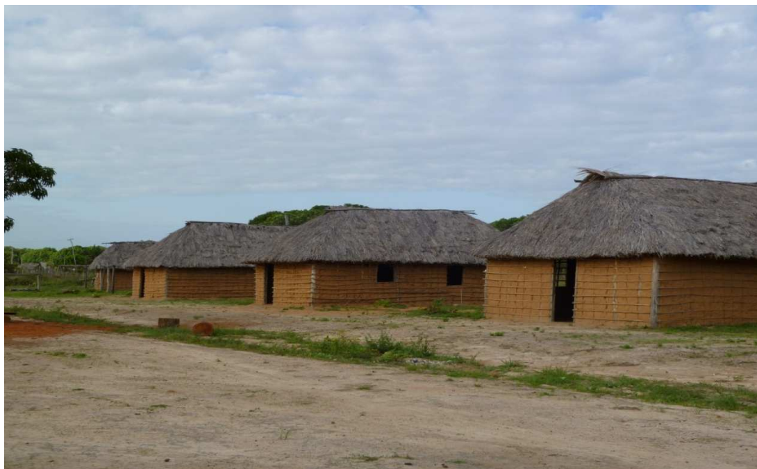
Foto 17- Residências construídas na comunidade Araçá especificamente para alojar as comunidades que participam de eventos
