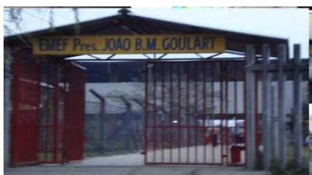
Escola Municipal de Ensino Fundamental João Goulart.
