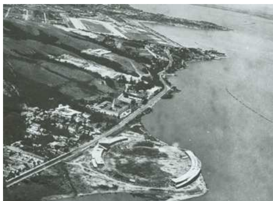
FIGURA 11 – As primeiras formas do Estádio Beira-Rio no aterro feito no Rio Guaíba
