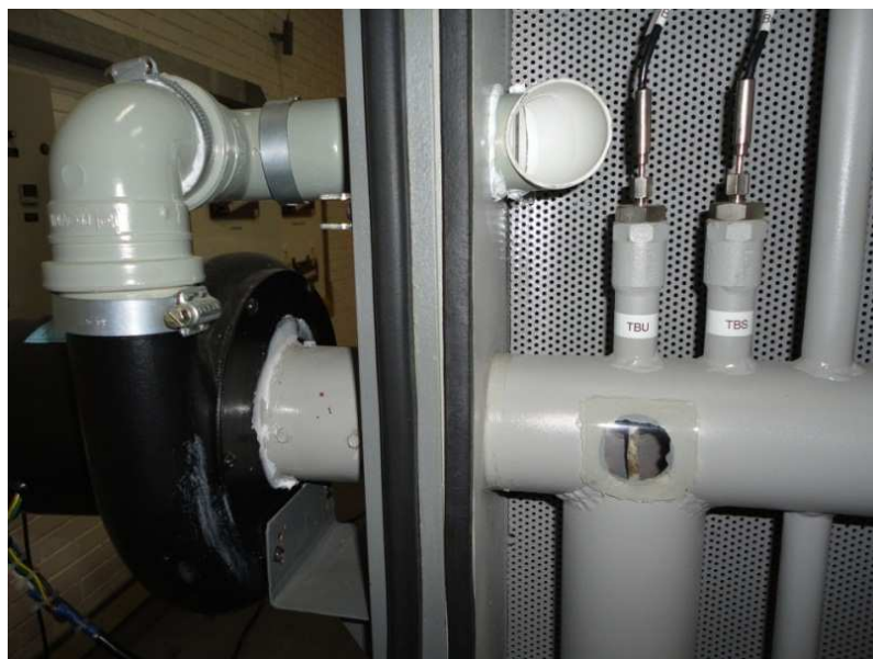
Figura 4.13 – Medição da temperatura do ar na entrada e saída do túnel.
