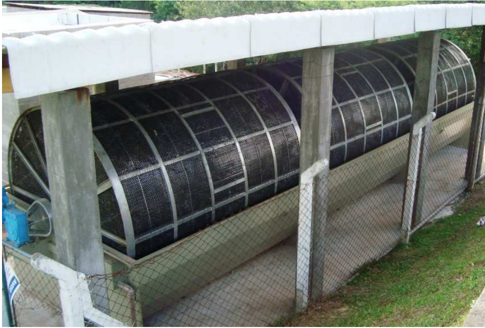
Figura 2 - Contactor biológico rotatório da ETE Unisinos - São Leopoldo/RS.
