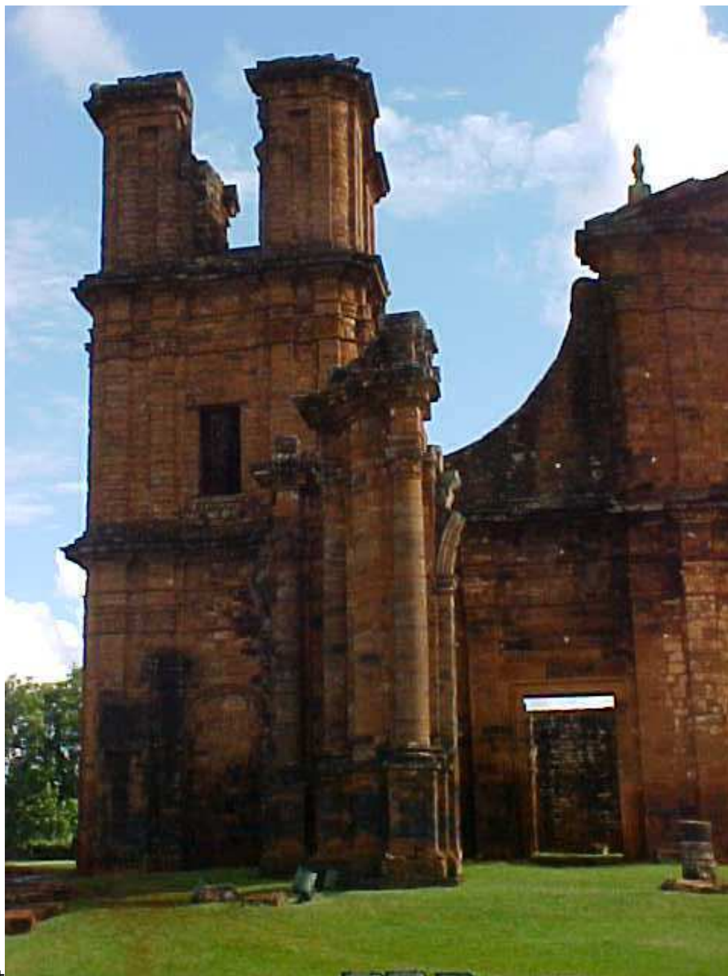
Fachada lateral atual da antiga igreja do povoado de São Miguel Arcanjo - Foto do Autor
