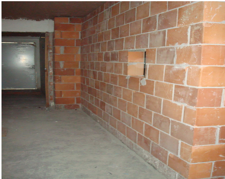
Figura 17: diferenças nas juntas de assentamento
