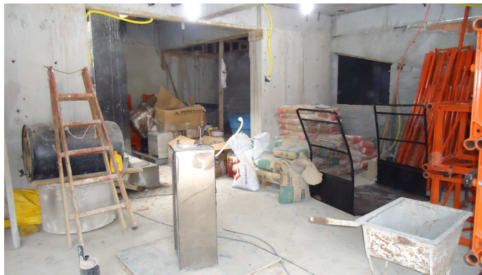
Figura14: aspecto geral da organização do canteiro
