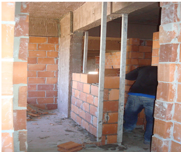
Figura 18: utilização de ferramentas adequadas para assentamento dos blocos
