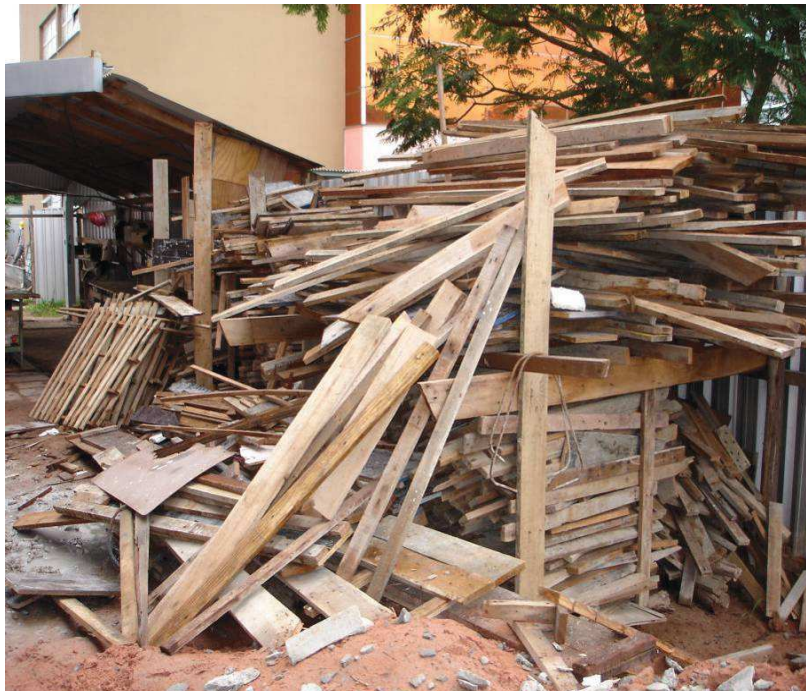
Figura 4.1: Armazenamento de resíduos de madeira em um canteiro de obras
