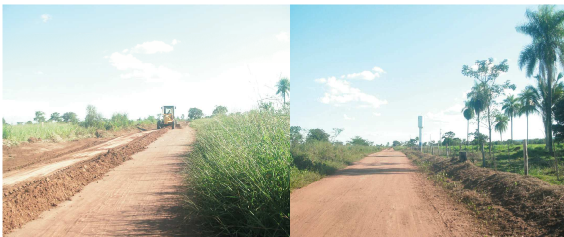
Foto do autor: Trabalho de uma patrula realizando obras de manutenção em estrada vicinal no assentamento Margarida Alves
