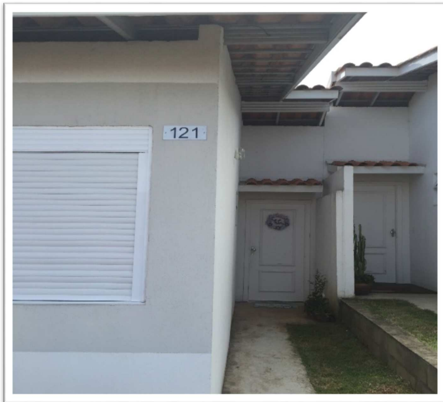
Figura 10 – Casa Nova da Gládis
