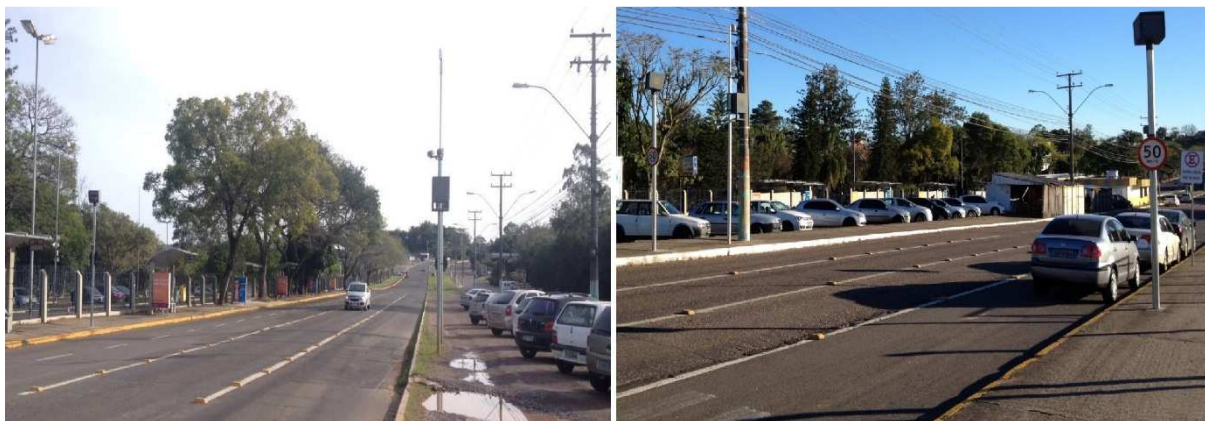
Figura 20 - Controlador sentido BR 116–Trensurb (a) e sentido Trensurb–BR 116 (b)
