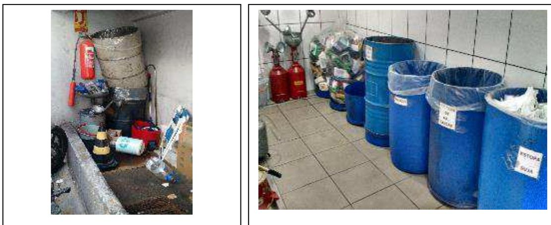
**Figura 18 – Locais de armazenamento dos resíduos, com e sem presença de contenção para evitar derramamento de óleo.**
