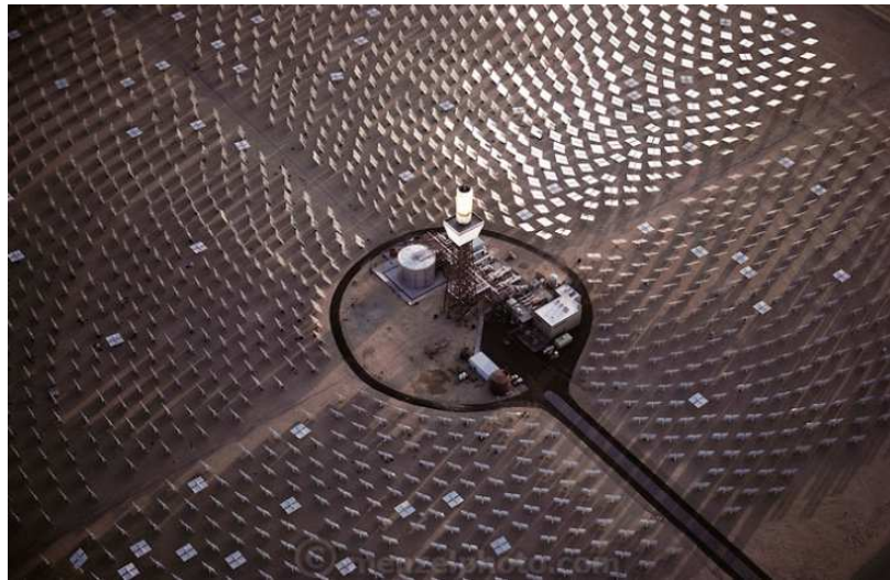
Figura 2.4 Planta solar tipo torre central SolarTwo, localizada nos EUA.
