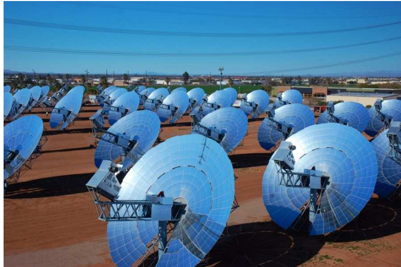
Figura 2.11 Detalhe de uma planta solar tipo disco parabólico, localizada no Arizona, EUA.
