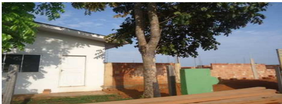
Figura 17 – Ampliação da Fábrica da COOPAVAM - 2016
