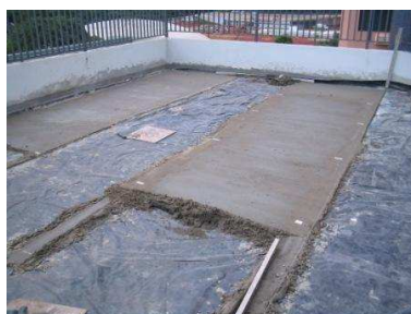
Figura 058– Camada de Proteção Mecânica
