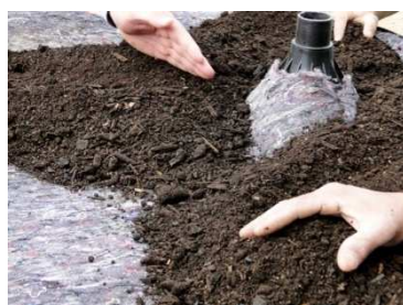
Figura 064– Preparação do Substrato sob a Camada Filtrante
