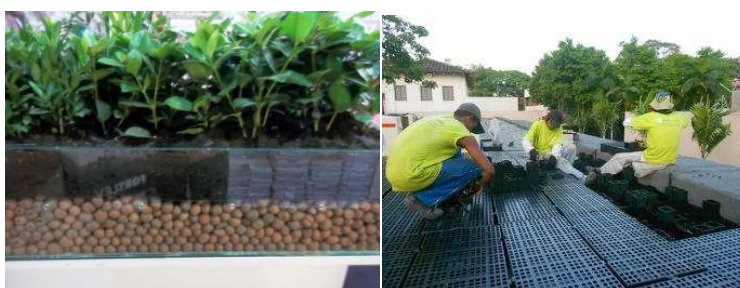
Figura 061– Camada drenante de Argila Expandida
