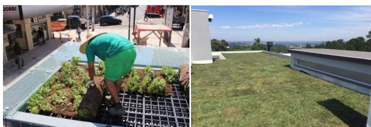
Figura 044 - Banca de Jornal com sistema Hidromodular da Ecotelhado - Canoas, RS
