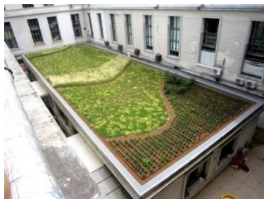
Figura 081 - Cobertura Vegetada na Faculdade de Direito da Universidade de Buenos Aires - Buenos Aires, Argentina
