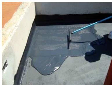
Figura 056– Aplicação da membrana fluída
