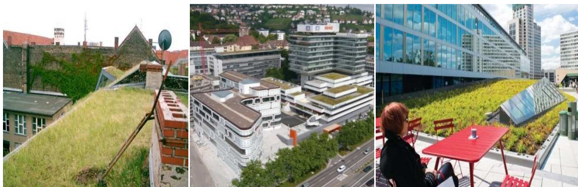
Figura 027 - Telhado Verde PLU - Berlin, Alemanha
