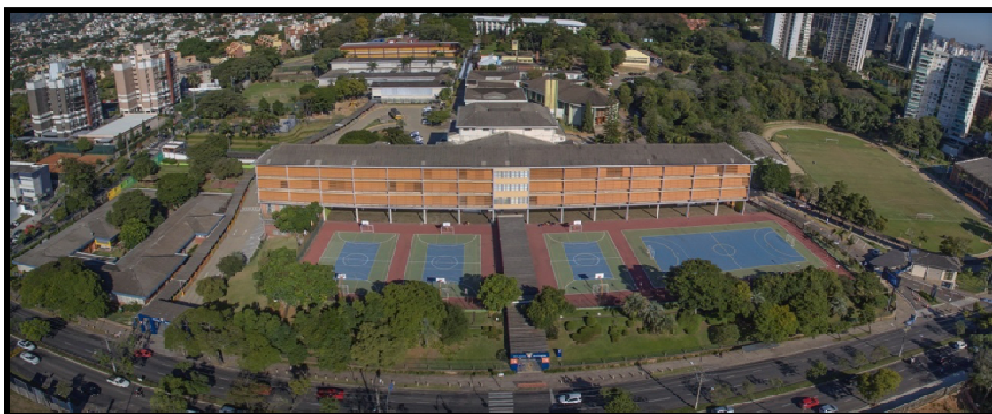
Figura 4 – Colégio Anchieta – Avenida Nilo Peçanha, 2016
