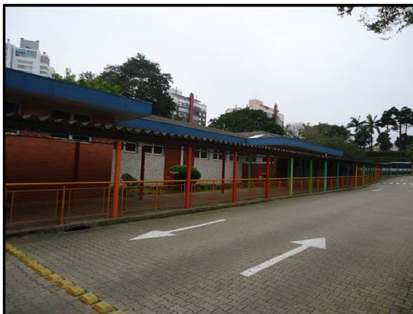
Figura A – Entrada principal do Prédio da Educação Infantil
