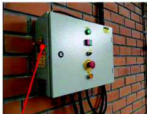
Chave seccionadora que permite o bloqueio
