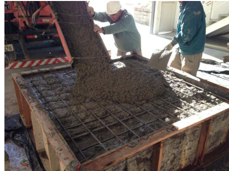
Figura 3(b): concretagem das formas com armadura.
