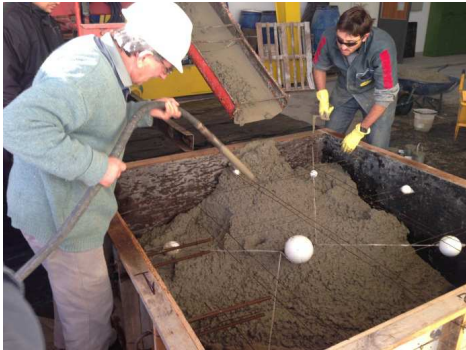
Figura 3(a): concretagem das formas sem armadura.
