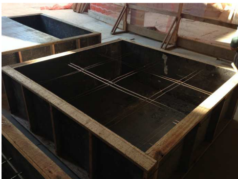
Figura 2(a): Formas sem armadura
