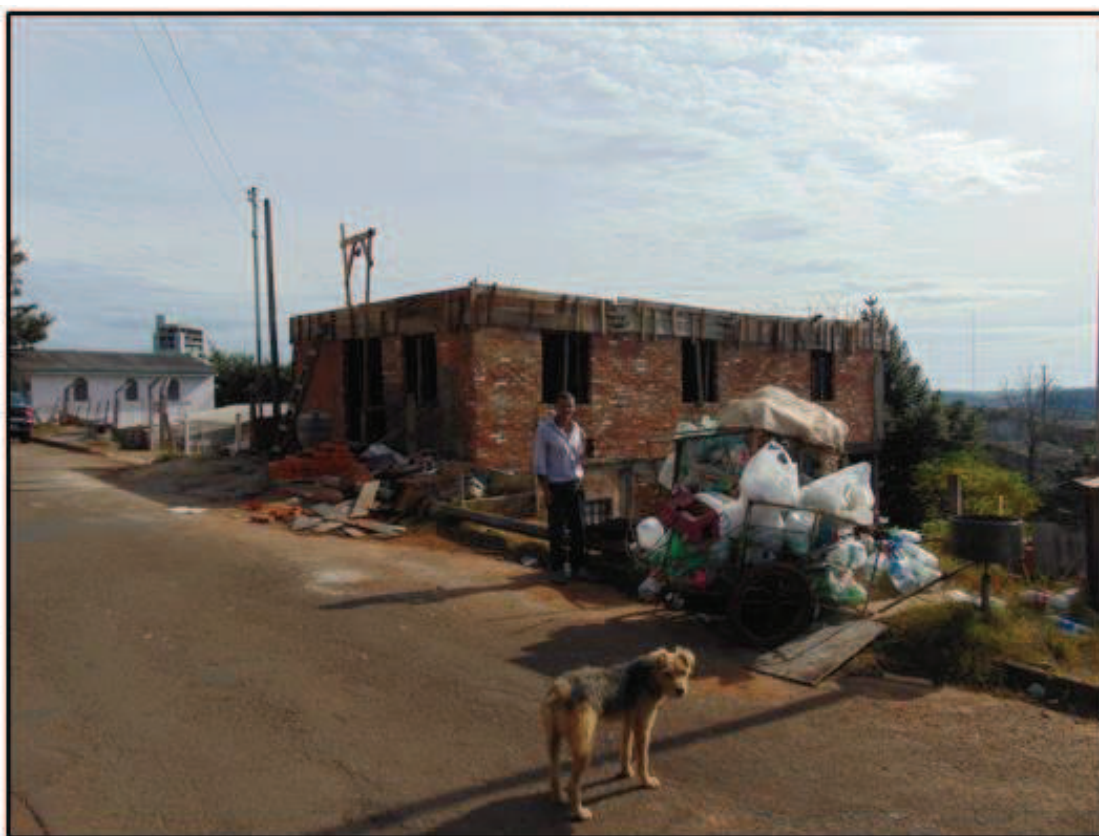
Fotografia 19 – Catador e a edificação de sua igreja evangélica
