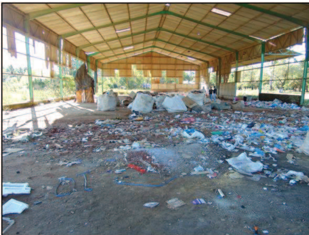
Fotografia 10 – Antigo galpão de armazenagem da CESA, destinado à Associação de Catadores Tropeiros de Passo Fundo
