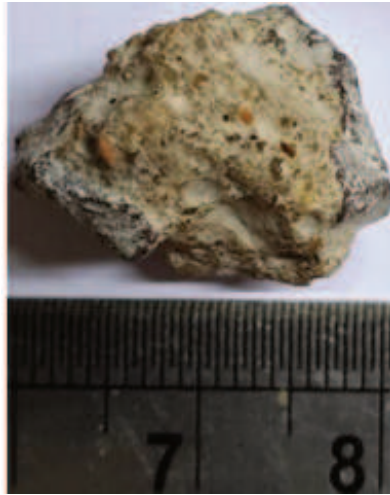
Figura 6 - Aparência do AGRC com camada de argamassa aderida ao grão
