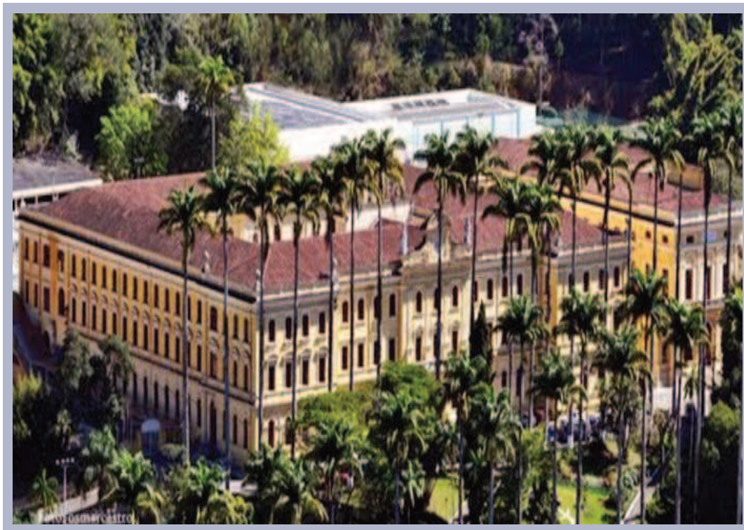
Figura 25: Vista aérea do Colégio Anchieta de Nova Friburgo (RJ)
