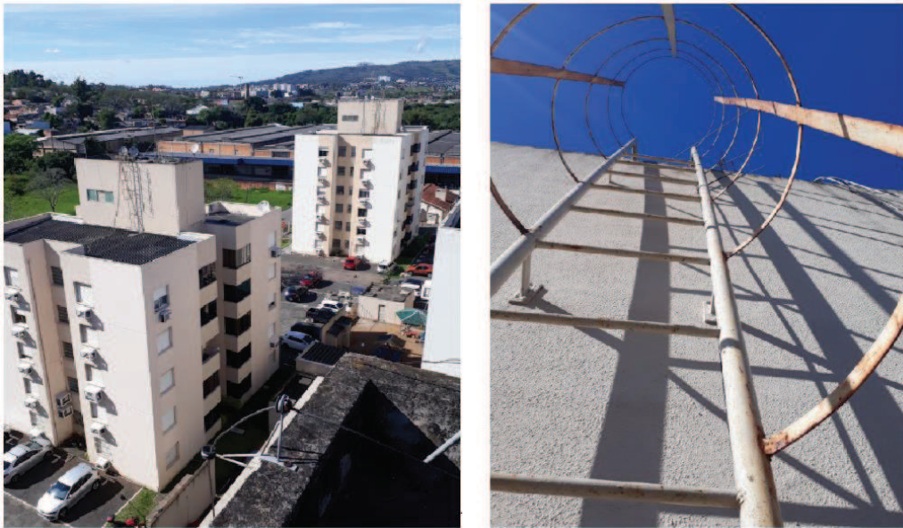
Figura 7 – Localização e acesso aos reservatórios
