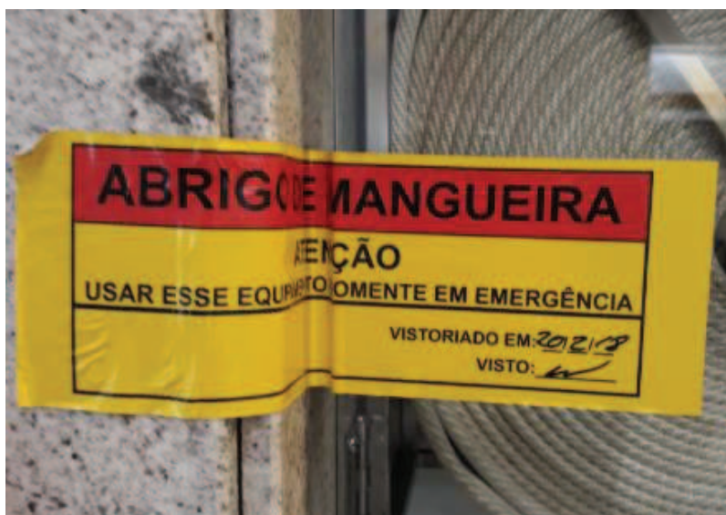
Figura 11 – Modelo de lacre de abrigo de hidrantes
