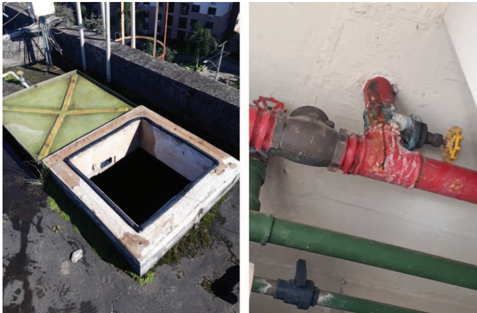
Figura 8 – Abertura de acesso e fundo do reservatório
