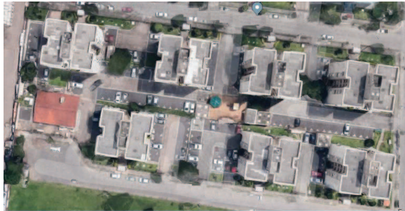
Figura 2 – Vista aérea do condomínio
