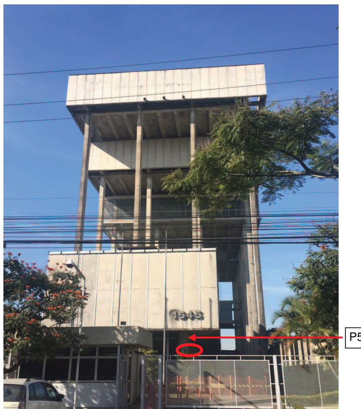
Figura 9 - Marcação dos pilares- frente da edificação, lado direito
