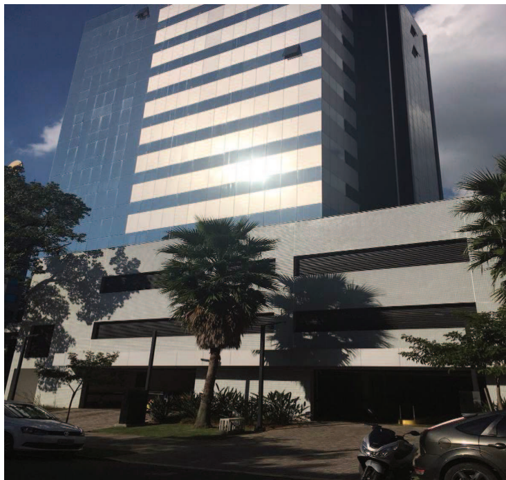
Figura 16 - Vista Lateral Edifício.
