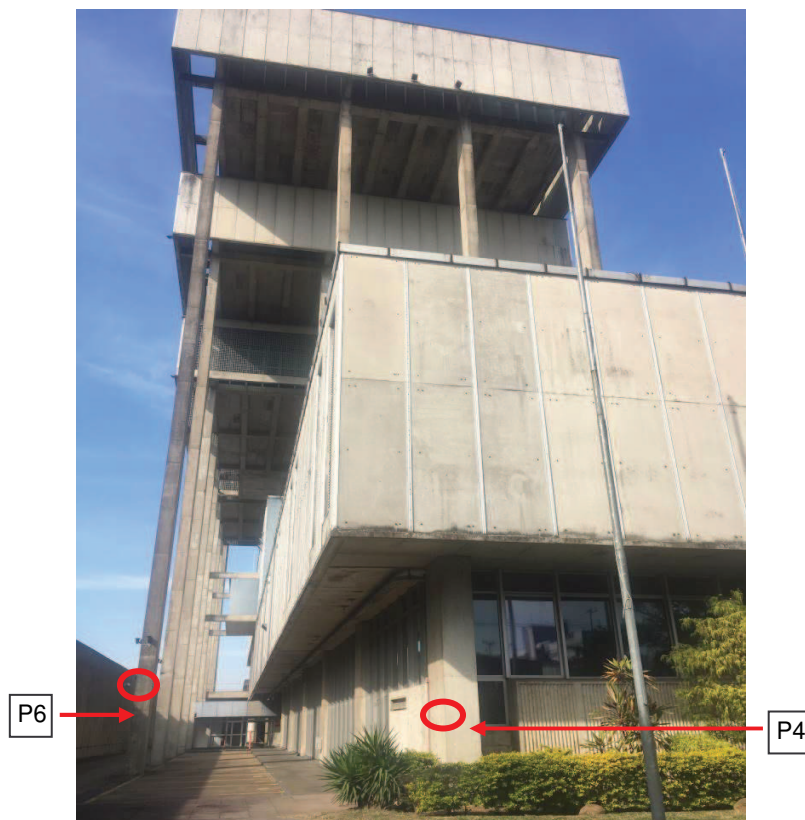
Figura 8- Marcação dos pilares - frente da edificação, lado esquerdo
