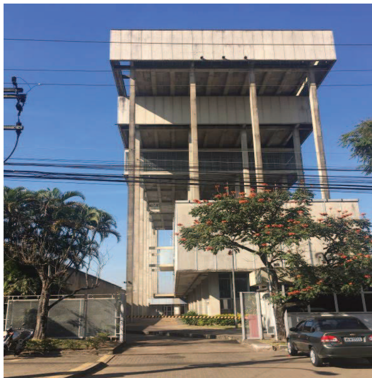
Figura 6 – Fachada do edifício
