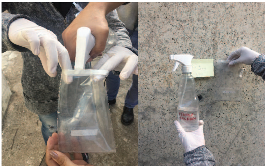
Figura 24- Aplicação de fenolftaleína para indicativo de carbonatação
