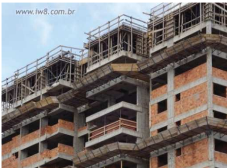
Madeiramento provisório para EPC
