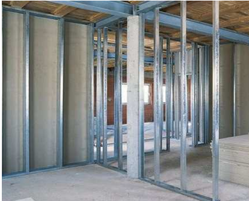
Figura 24 - Paredes internas em sistema drywall
